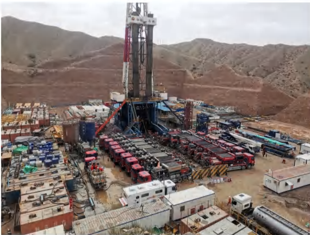
库探1井施工作业现场
