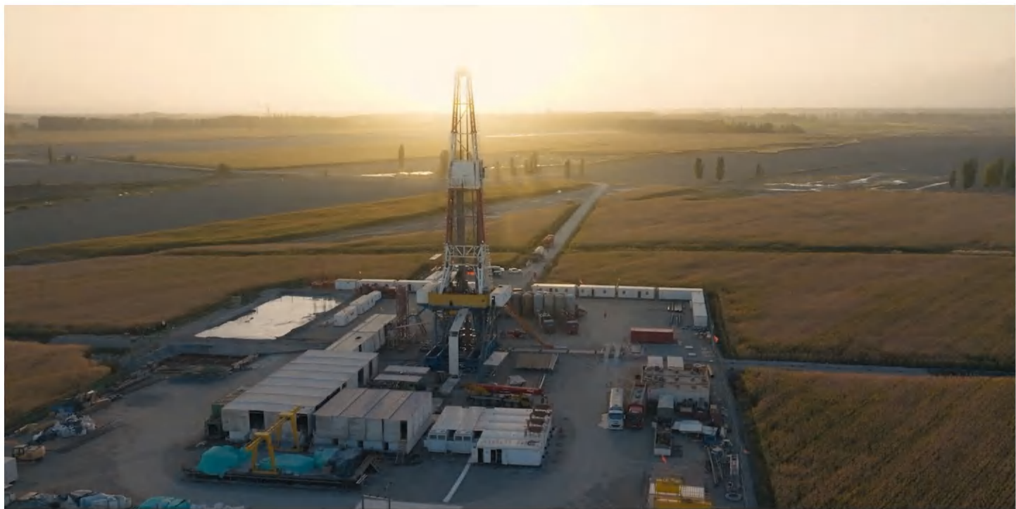
日出中的新疆固井作业现场
