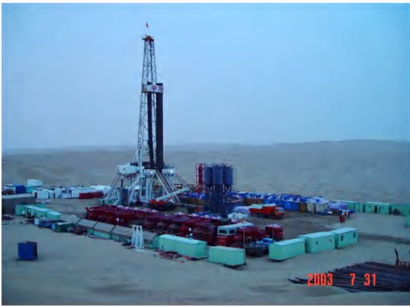
2003年满东1井压裂酸化作业现场
