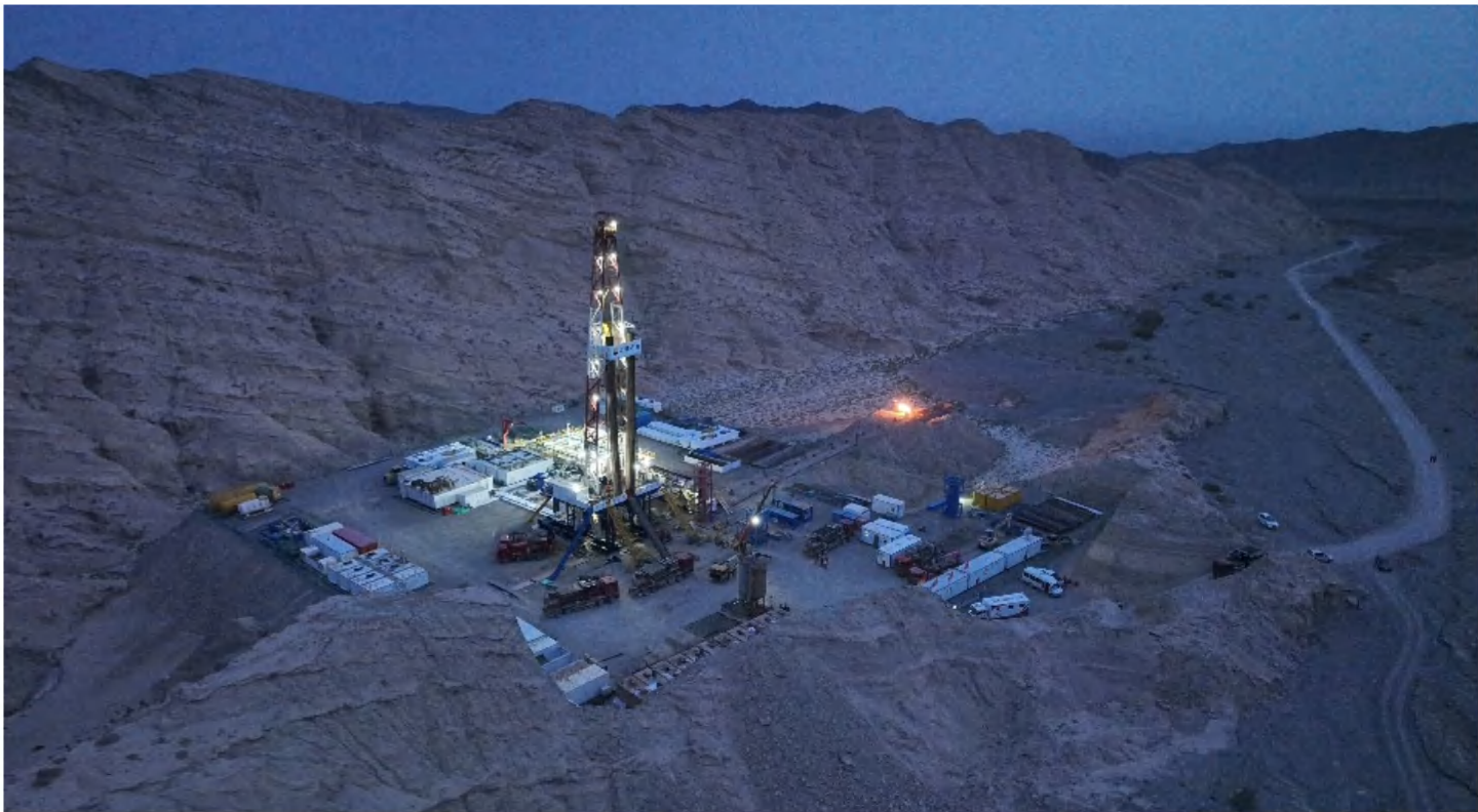
夜幕中的土东302井施工现场
