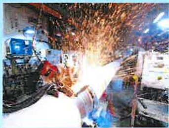
工人正在进行管段切割和焊接作业。
