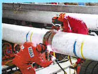
工人正在安装海管管段。
