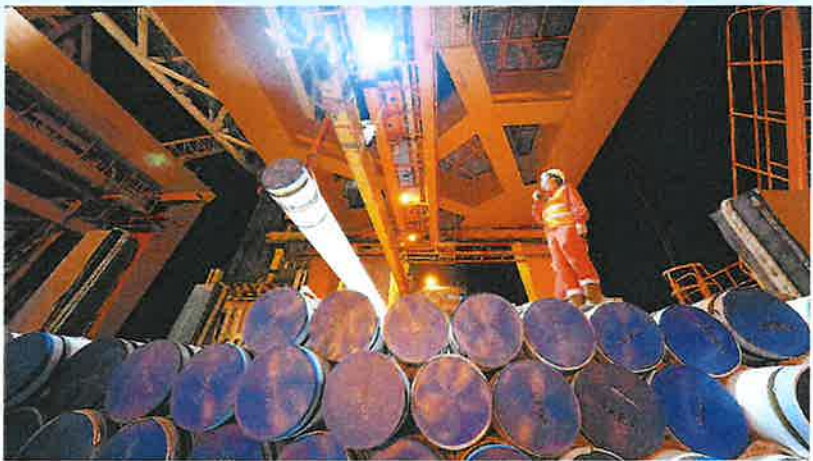
工人正在检查海管管段对接位置。
