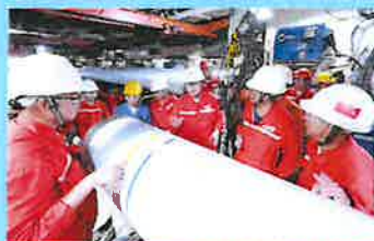
管段吊装，准备进行管段对接作业。
