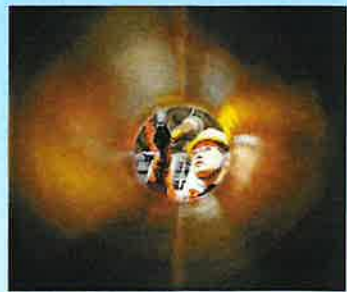
工人正在检查海管管段对接位置。
