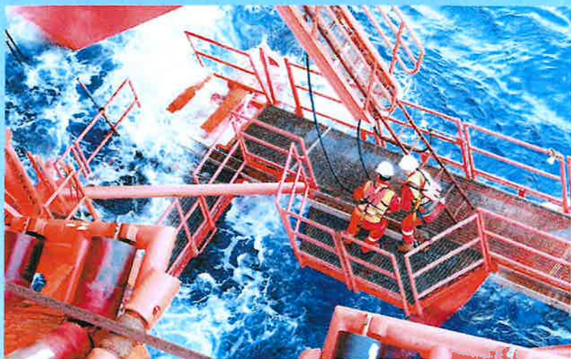
工人正在检查海管管段对接位置。
