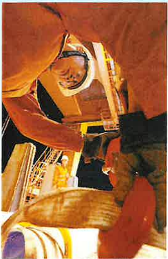
工人正在进行管段切割和焊接作业。
