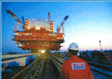
工人平台开始浮托安装工作。杜晓峰 摄
