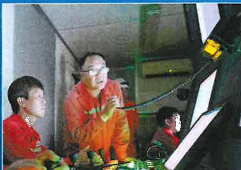
施工人员进行视频校核,确保设备精准定位。韩庆 摄
