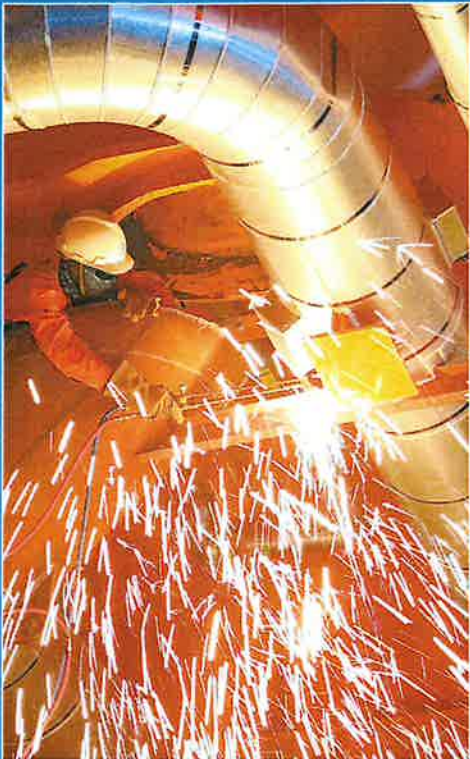
凌晨,工人正在进行焊接作业。杜晓峰 摄
