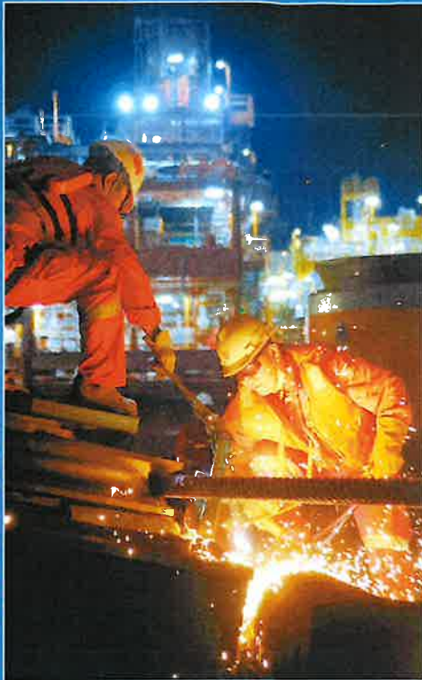
施工人员进行管架模块与船体之间的初作业。韩庆 摄
