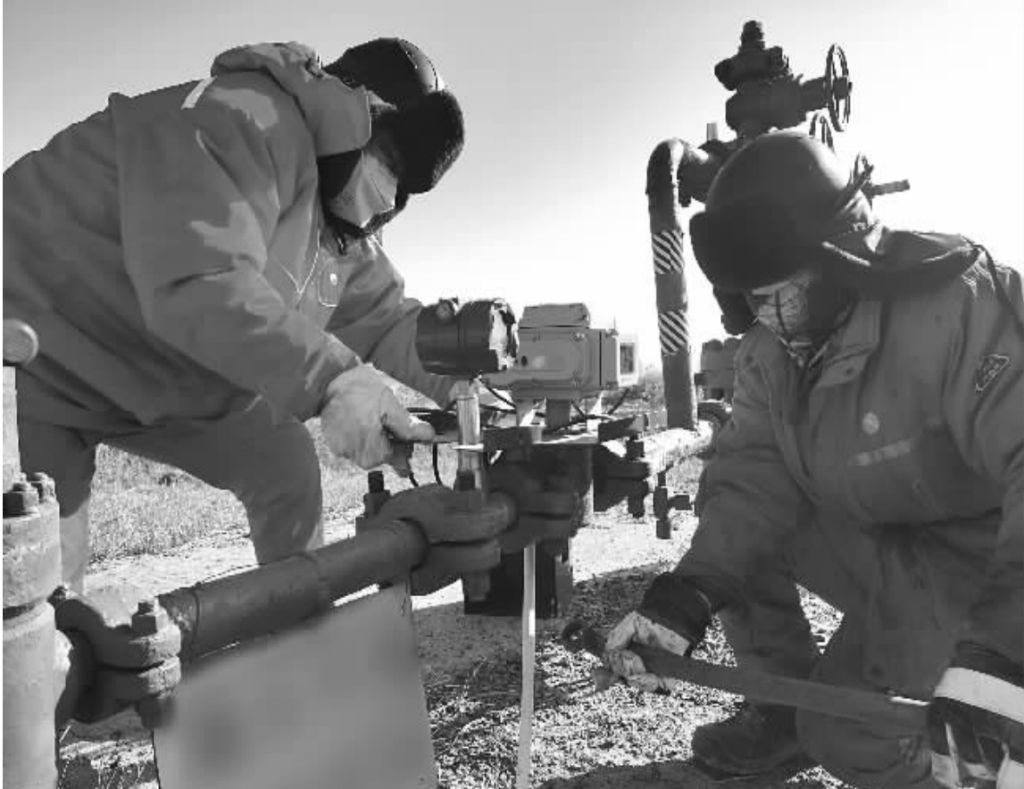
入冬以来,采油三厂五区采注运维三组持续开展“安全隐患大扫除”活动,针对设备设施、疫情防控、消防器材等方面展开检查。图为该组员工正在清理官新 969 井流量计。
