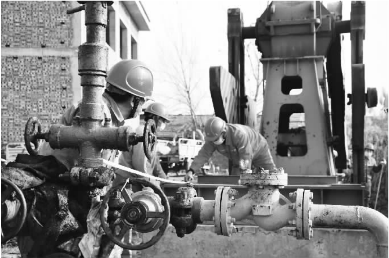
入冬以来,采油三厂作业二区严格落实冬季“八防”措施,优化生产组织,着力提速提效。近日,风 37-21 井检泵作业,该区管理四站仅用 3 个小时完成该井移动、抽油机组装工作,为油井及时复产抢得先机。
