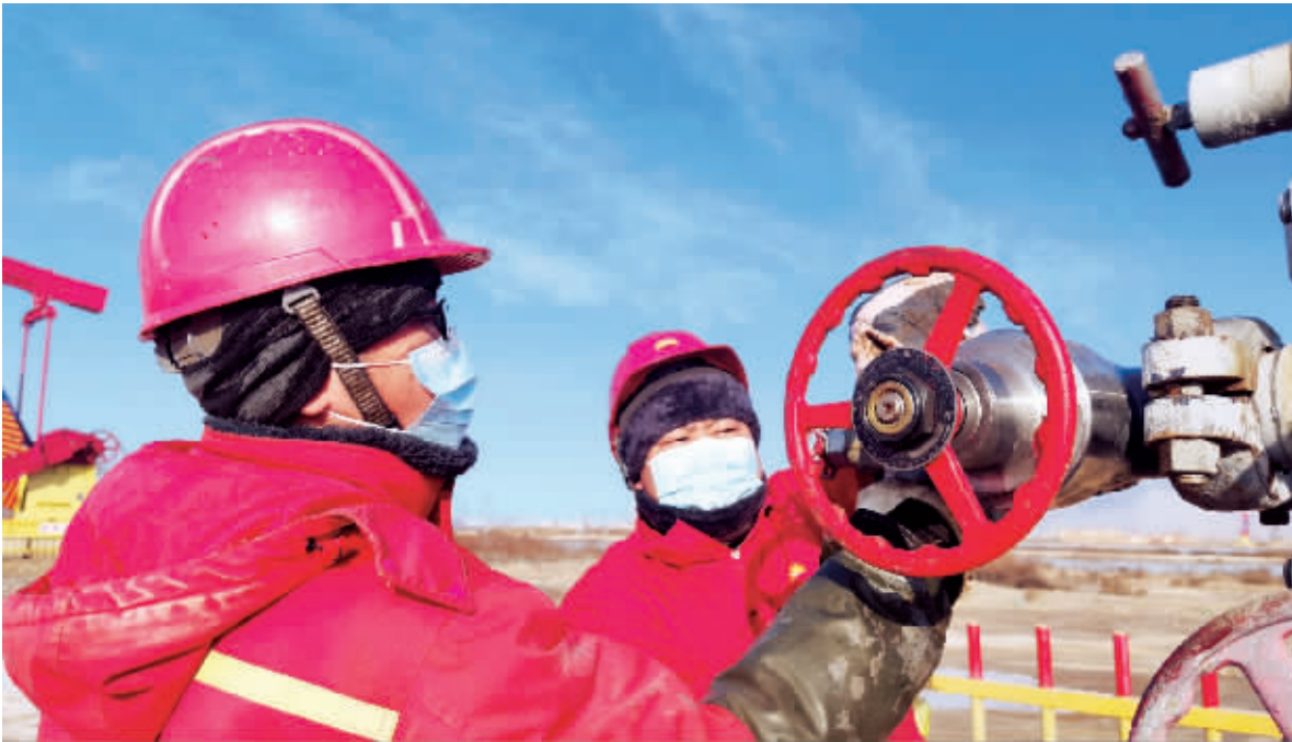
采油一厂作业二区瞄准生产目标，精心安排部署，确保设备安全越冬。严格执行“一井一策”制度，加大油水井资料录取和巡检力度，找准问题根源，通过自我加压持续加强冬季生产管理。图为岗位员工更换油井生产阀门。（通讯员 张旭）
