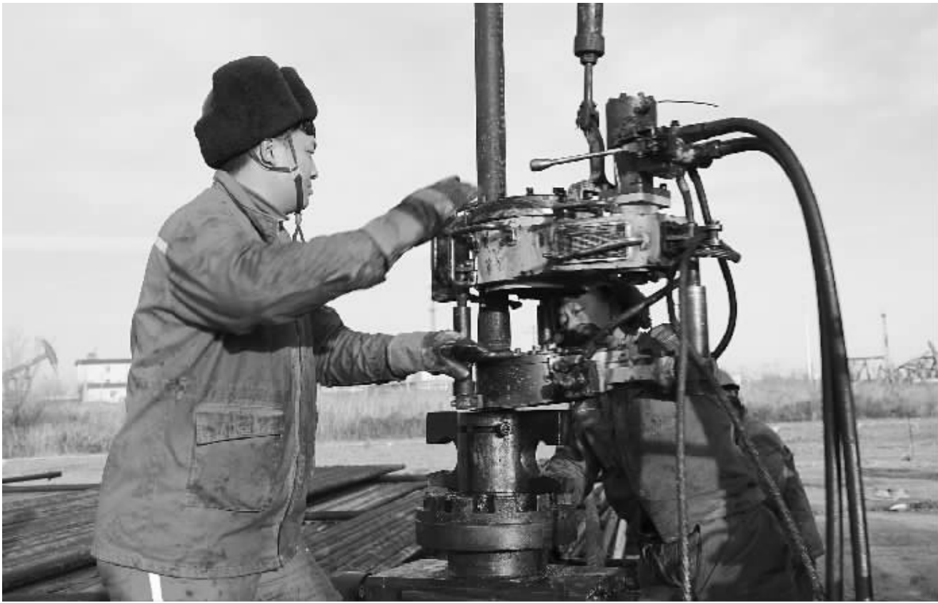
四季度,井下作业公司深入落实油田公司油气稳上产工作举措,统筹抓好修井运行、安全生产、提质增效等工作,累计完成各类修井作业 783 口,其中增产措施井 147 口,日增油 387.1 吨。图为修井员工操作液压钳为油管上扣。(特约记者 代中专)
