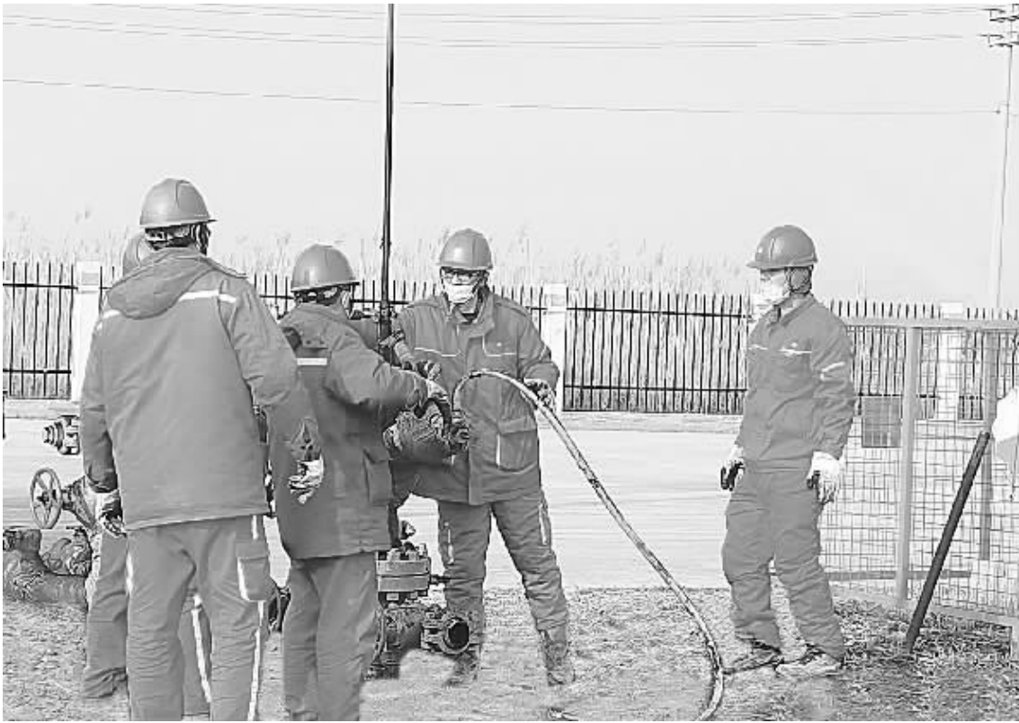
采油三厂作业六区盯紧产量目标,加快上产衔接运行,积极处置突发事件,加强施工现场安全监控,确保年终岁末安全、产量完美收官。图为小 13 站员工在官 16-8 井更换光杆。(通讯员 蒋国震)
