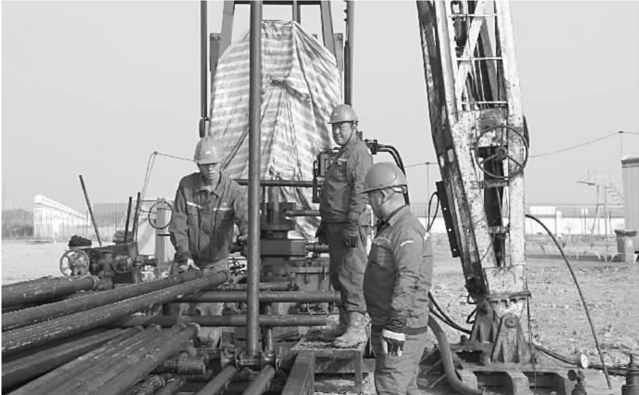
四季度以来,井下作业公司干部员工紧跟修井上产需求,强化动力、技术、物资等生产资源保障,全力打好奇油上产进攻仗。截至目前,完成各类修井作业427口,其中增产措施作业96口,日增油276.9吨。图为修井员工在东7-37井进行起管柱作业。
