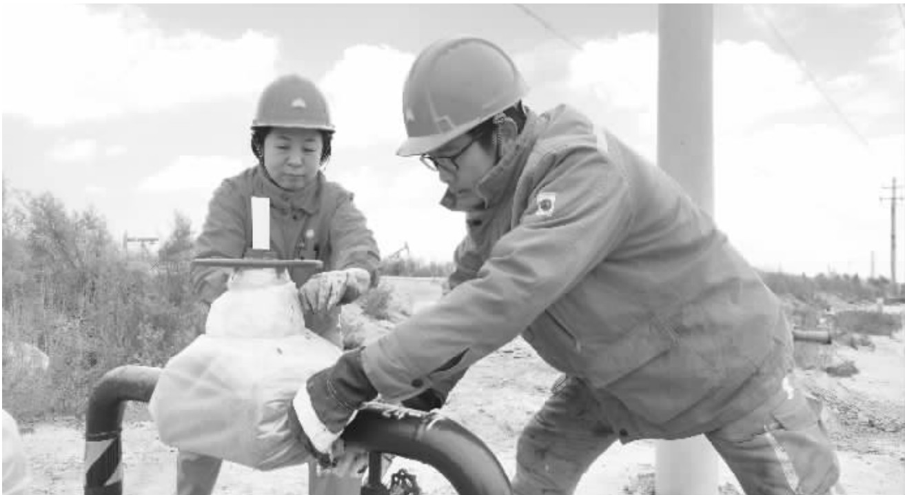
四季度以来，采油一厂作业二区积极备战冬季生产，以“不冻坏一台设备、不冻堵一条管线、不发生一起冻伤事故”为目标，细致开展冬防保温工作，确保设备安全过冬。图为该区员工正在包扎井口设备。（通讯员 张旭）
