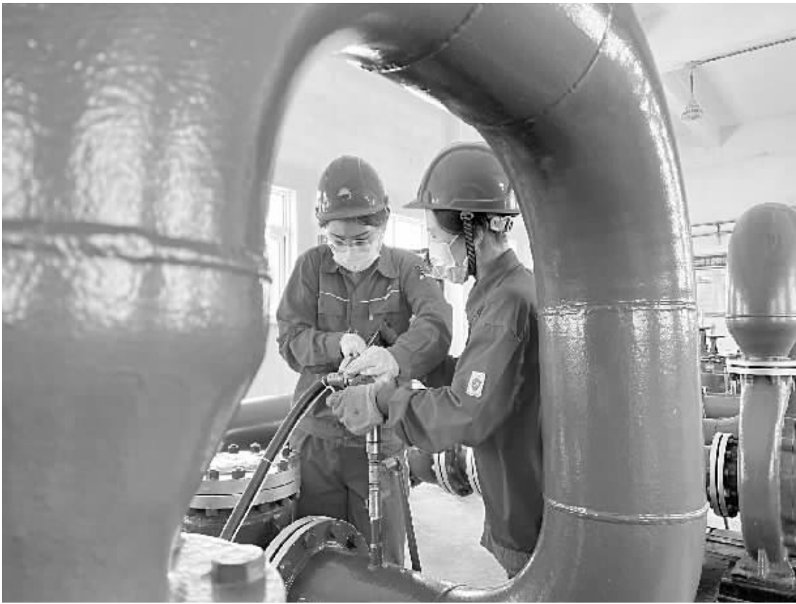
11月份以来,采油一厂作业四区马西联合站不定期开展拉网式排查,全面分析生产中存在的隐患和漏洞,对各岗位安全防护工作进行监督提醒,全面提升物防、人防、技防综合能力,确保冬季生产安全平稳运行。图为该站员工正在整改安全隐患。(通讯员 侯 琳)
