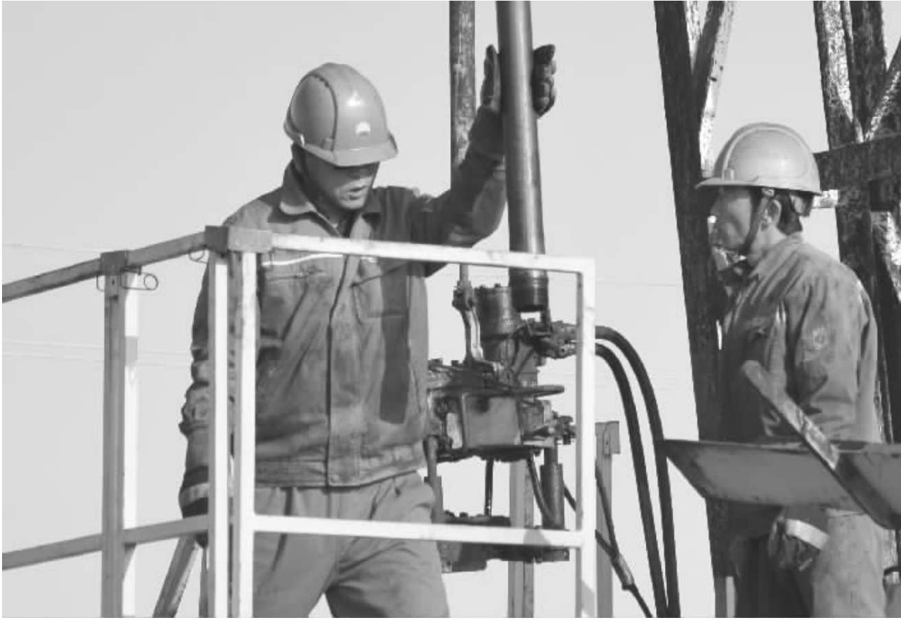
11月份以来,井下一修井合理配置资源,高效组织生产运行,严格现场安全管控,又快又好推进油井上修工作,切实履行好保油上产第一责任。图为井下作业107队员工在中7-53-2井实施起油管作业。(特约记者 任爱花)
