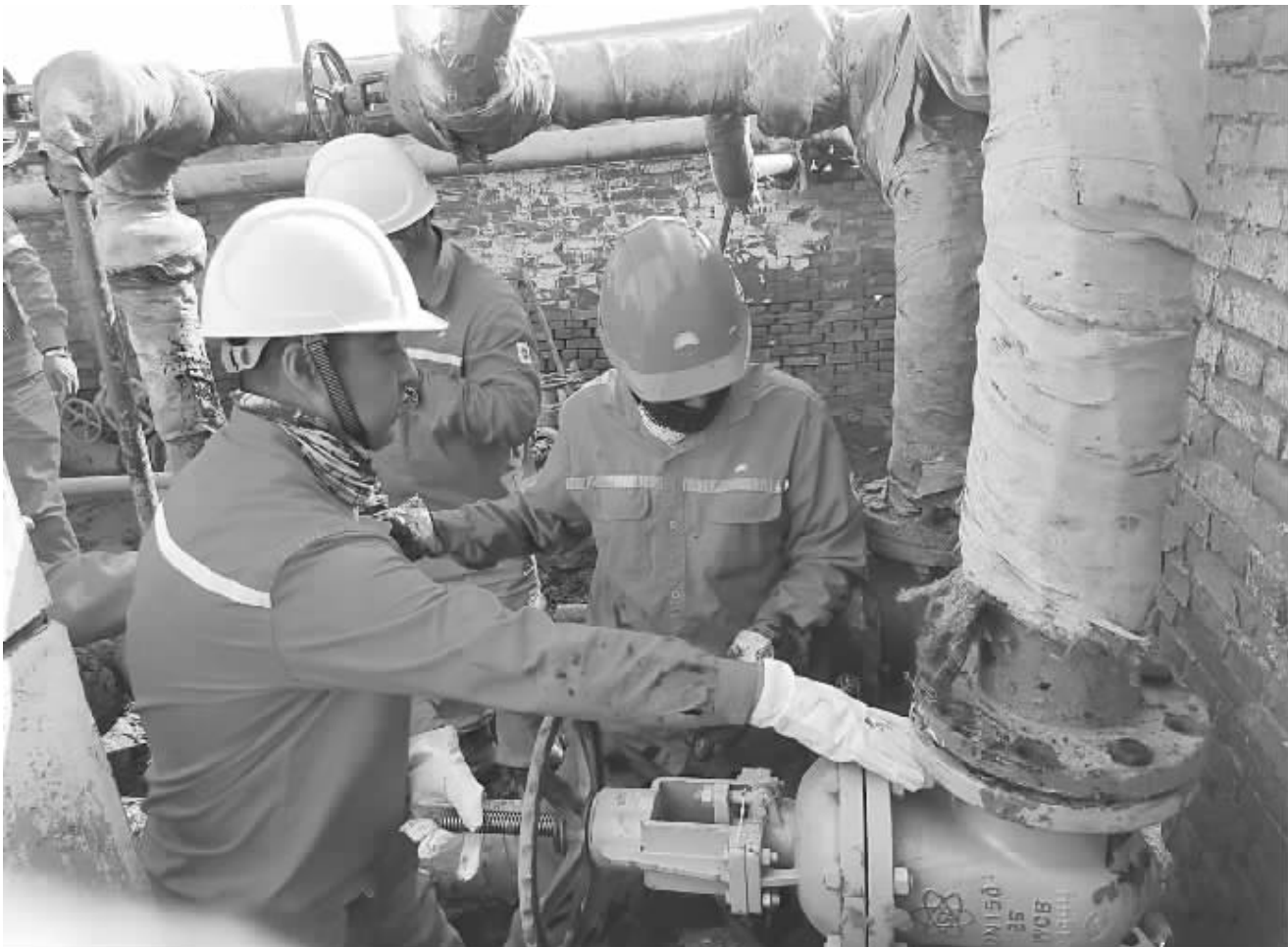
采油三厂作业五区抓住原油上产的有利时期,加强油井管理,优化生产组织,确保稳产上产。近日,该区组织员工对王十五站回油干线直通阀门、官 27-50 井进系统闸门、页岩油串井进干线闸门进行更换,及时消除隐患,保证设备平稳运行。
