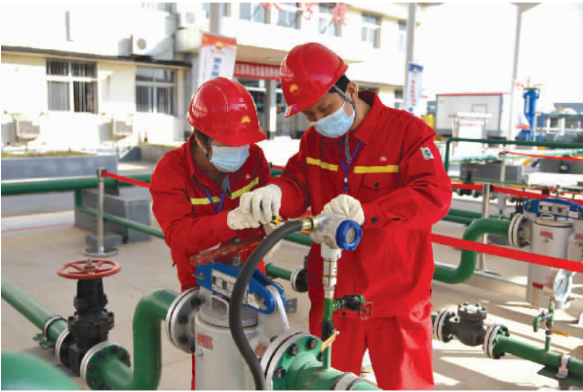
10月18日至21日,采油三厂“大学习 大练兵 大比武”暨第五届职业技能竞赛成功举办。图为集输工种正在进行的更换压力变送器技能操作项目的竞赛。
