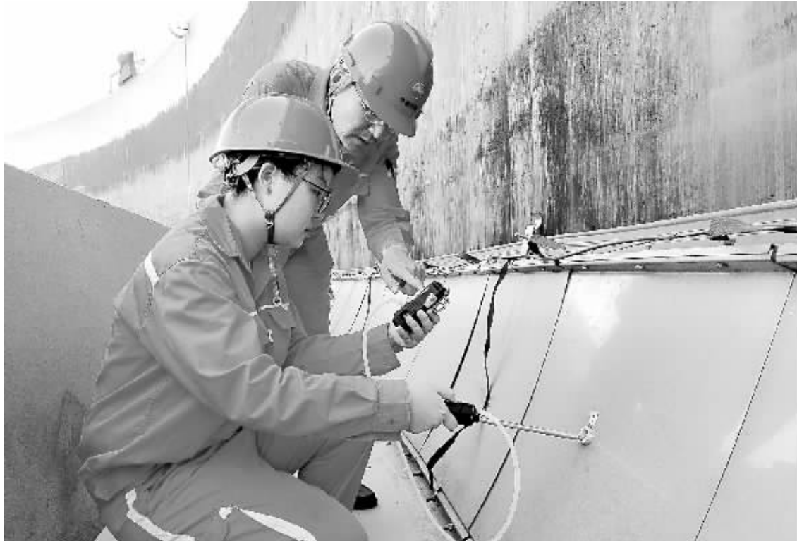
国庆节期间，原油运销公司储运计量作业区认真落实安全措施，强化现场安全监督管理，确保节日生产施工安全平稳运行。图为岗位员工在对1号储油罐进行可燃气体浓度检测。（通讯员吴磊）
