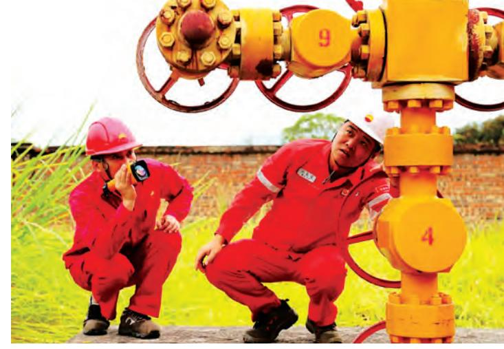
发现的卧31井、明1井、明2井等井口升高短接存在腐蚀的情况,立即研判风险,组织防腐与维护,测量管壁剩余厚度,核算抗压强度。制定泄压方案,根据气井地质情况及地面状况分析,因地制宜对四合1井B环空带压等进行泄压处理。落实有效的管控措施,做到心中有数,确保风险可控。
