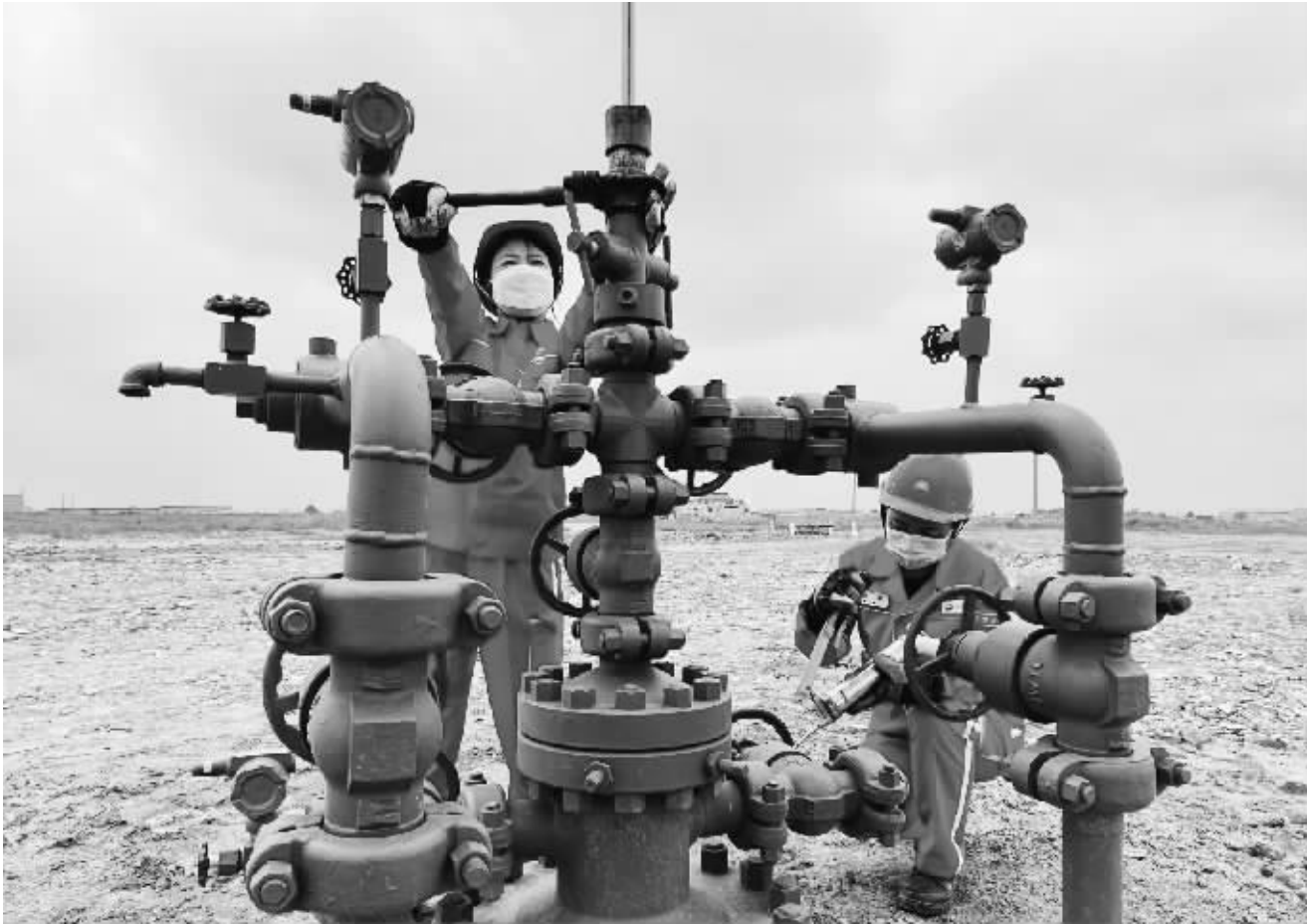
采油一厂作业四区将精细管理落实到班组、延伸到岗位,进一步加强油井护理。截至目前,发现变化井 125 井次,实施危险井抢救 21 井次,挽回产量 2500 余吨。图为该区员工正在巡护油井。(特约记者 刘淑瑞)
