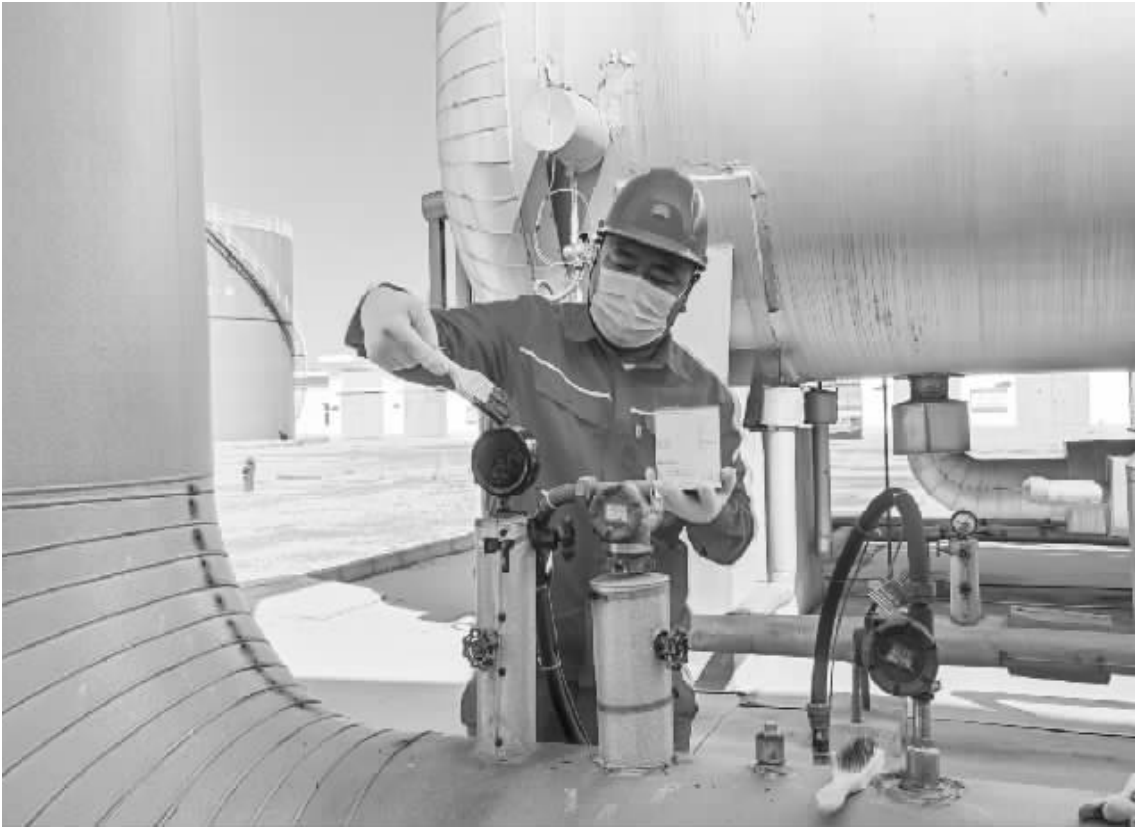
采油四厂(滩海)集输作业区对所属区域压力表开展除锈刷漆保养作业，延长仪表使用寿命，为夺油上产提供有力保障。截至目前，班组员工刷涂压力表 32 块、双金属温度计 5 块，减少后期采购费用 2000 余元。(通讯员 陈浩)
