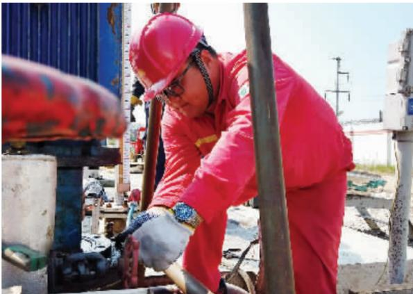
采油四厂(滩海)滩海集输作业区员工拆除机泵底座。(张宇锋)
