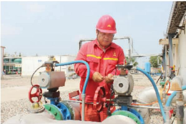
采油五厂二区员工在进行核桃壳反冲洗操作中更换电磁阀。(韩丽)
