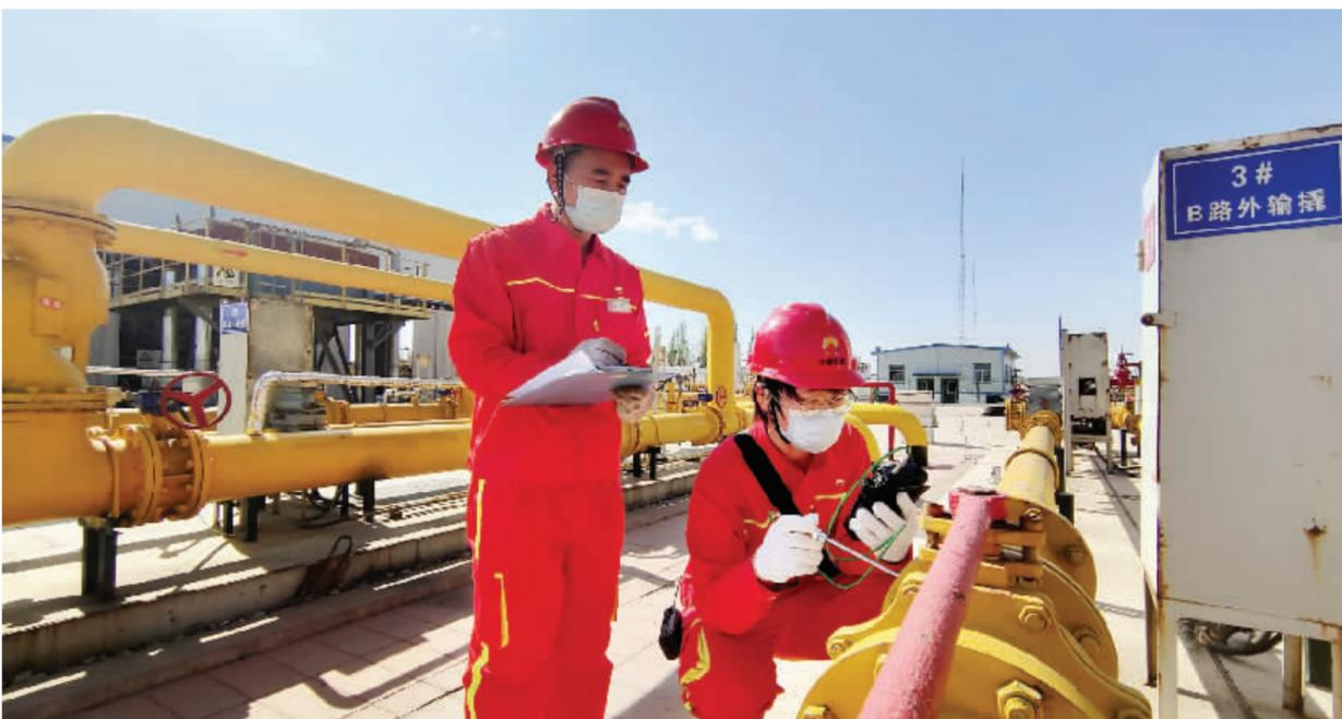
原油运销保2集气站员工对法兰连接部位进行验漏。(刘天伯)
