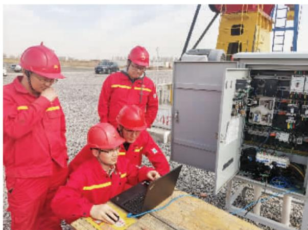
大港油田积极构建新型井站一体化智能管控生产组织模式,推动油水井实现数字化全覆盖。图为油井控制柜智能化升级改造现场。
