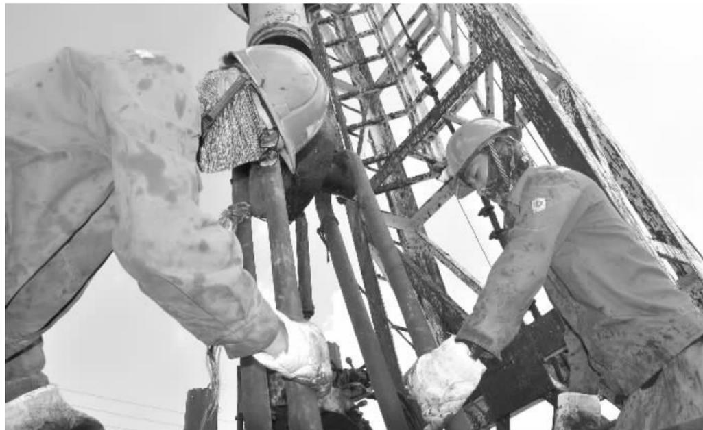
立秋以来,井下作业第二修井分公司采取增开动力、增加夜班等方式,加快躺井恢复和措施上产的生产步伐,抢抓夺油上产主动权。图为 202 队在庄 4-24K 井进行提探灰面管柱作业。(特约记者 李镇)
