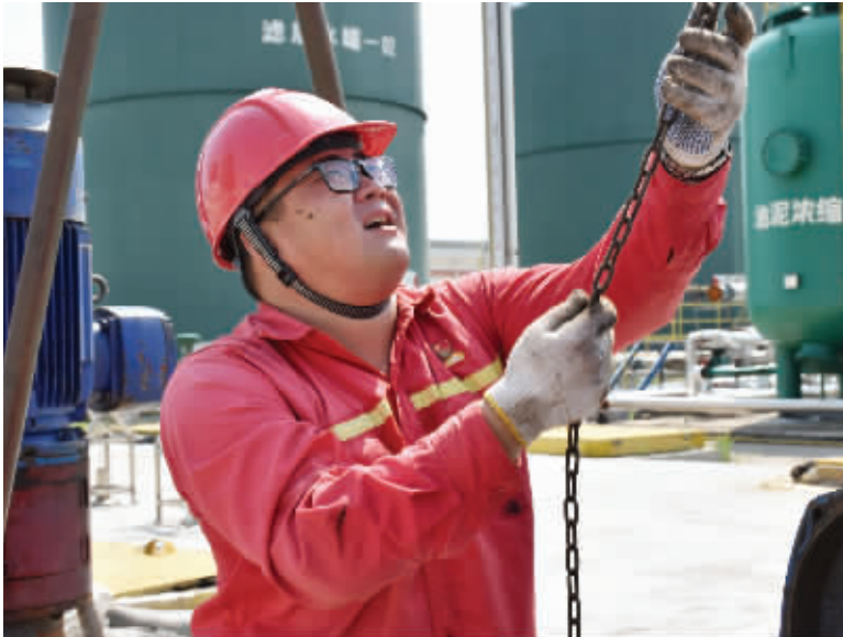
采油四厂(滩海)滩海集输作业区员工用倒链吊起机泵准备维修。(张宇锋)
