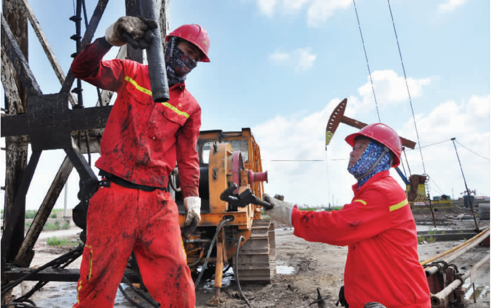
井下作业二修井 202 队在庄 4-24K 提探灰面管柱作业。
