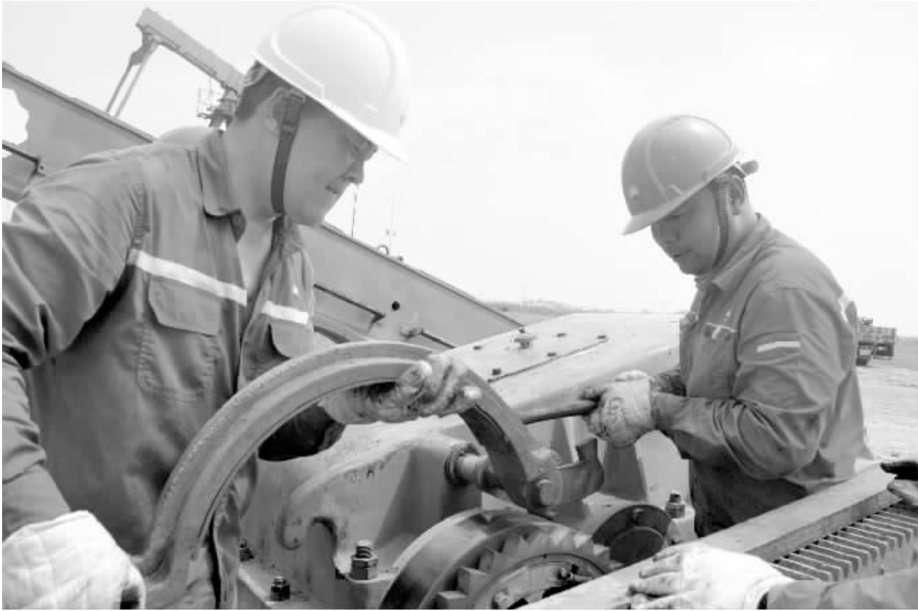
8 月份以来,面对高温多雨天气,采油三厂三区加强隐患排查治理,及时整改设备、油水井及系统管网存在的隐患,确保生产平稳运行。图为岗位员工正在为 32-44 抽油机井更换减速箱。
