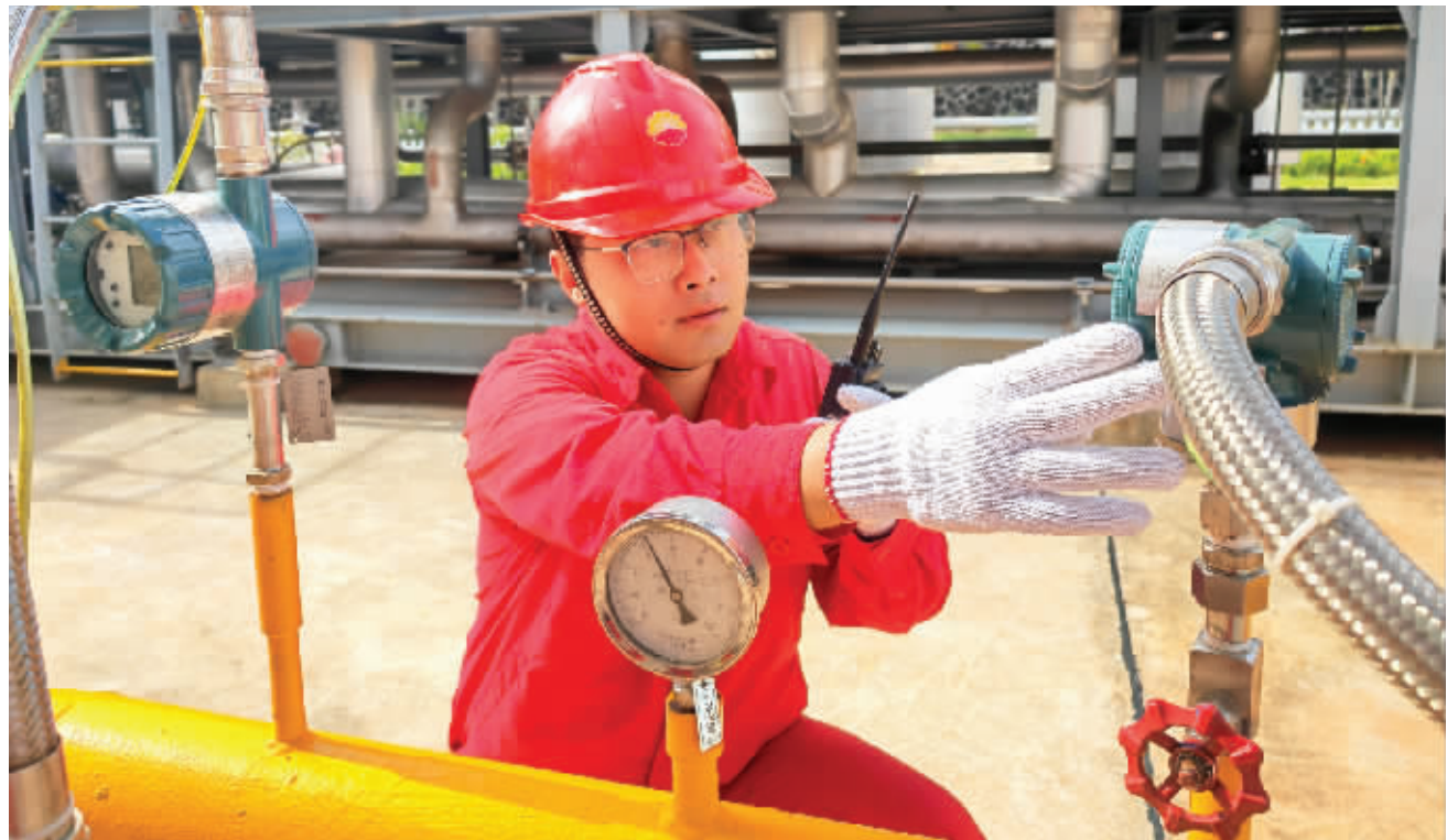
天然气公司海南项目部维修班员工对压力变送器进行检查,保障输气管道安全平稳运行。(张宏超)
