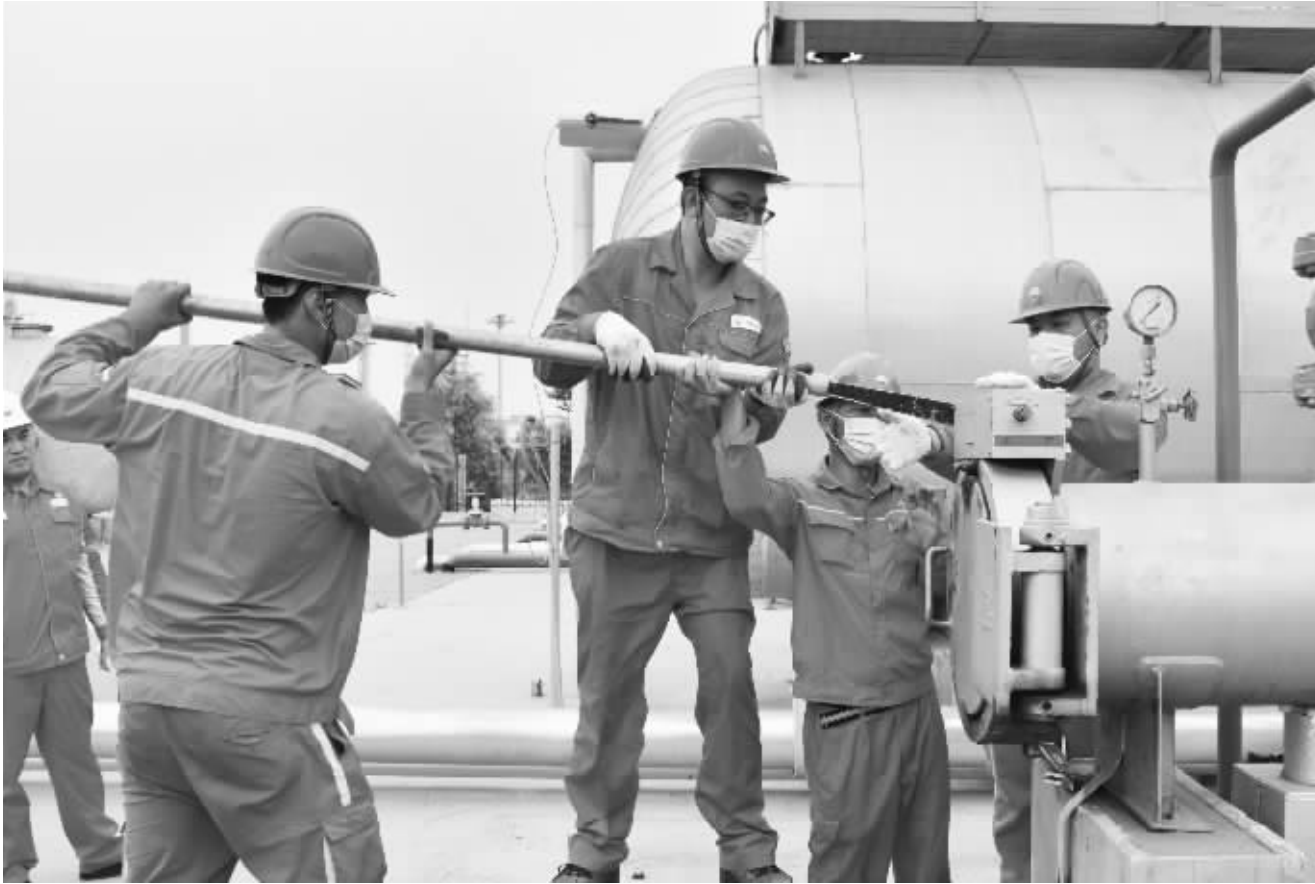
为及时准确掌握板中管线上游来液情况,天然气集输管理站日前按照计划顺利完成板中管线清管作业。日前,该站加强日常生产来液数据分析,持续关注管道运行情况,为今冬季天然气保供提前筑牢基础。(通讯员 李璐璐)
