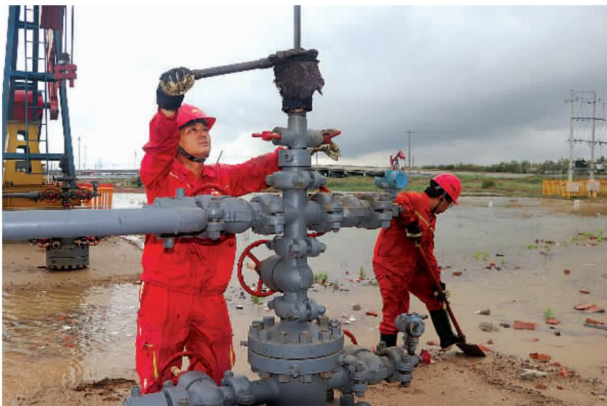
采油一厂作业一区以汛为令，准备铁锹、铁钩、撬杠等防汛工具及物资，对水淹严重的井场实施引流排水，确保雨天巡井工作的正常运转。图为作业区员工进行雨后井场维护、电路检查。(特约记者 明洁)
