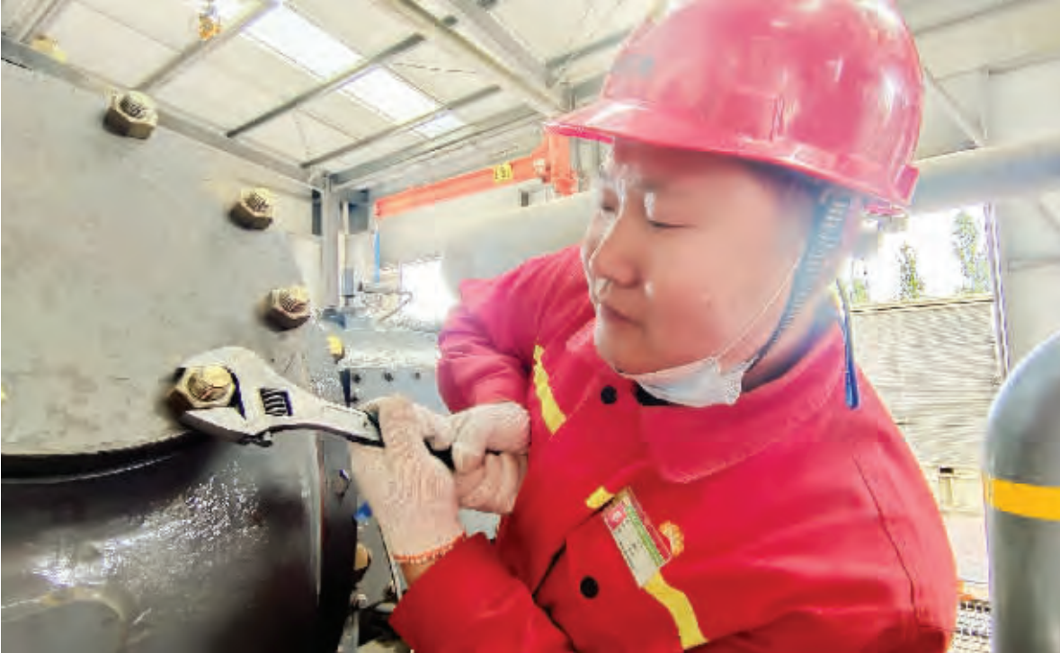
原油运销公司煤层气忻州(技术服务)项目部保 2 集气站员工在紧固压缩机缸盖螺栓。(刘天伯)
