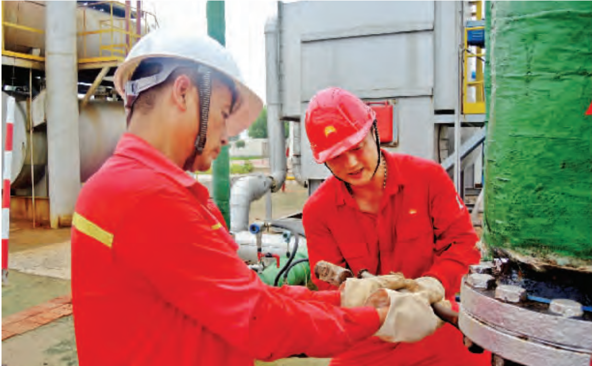
采油三厂集输作业区员工在加热炉区域更换掺水炉出口阀门。(杨玲玉)
