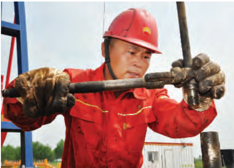
井下作业二修井 203 队员工在羊 10-8-1 井配合技术服务方做油管电切割前的施工准备工作。(李镇)
