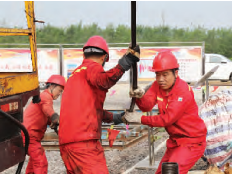
井下作业四修井 402 队员工在西 5-15-3 井抽取电泵电缆作业。(张鹏)
