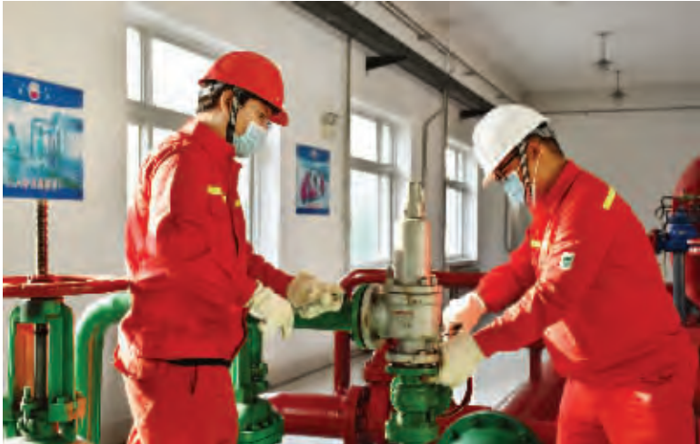
采油一厂输注作业区员工在卸载消防泵房内的安全阀。(王洪珍)
