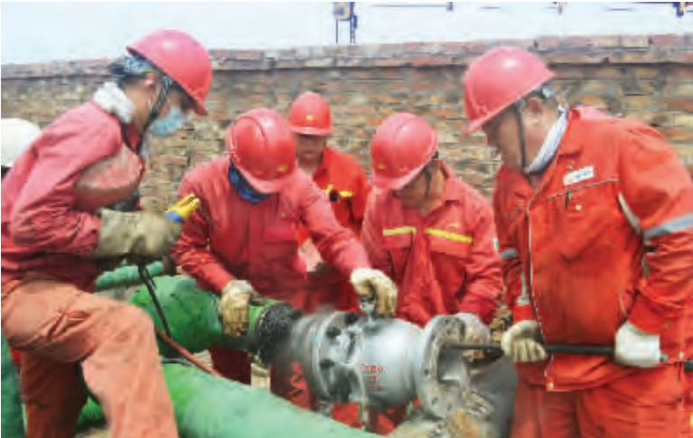
采油三厂作业三区采注运维三组员工给官 195 掺水系统加装过滤器。(张瑞霞)
