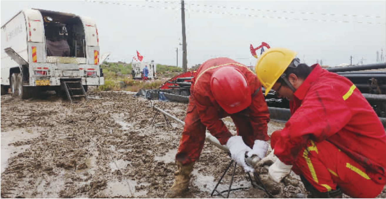
夺油上产“百日会战”以来,测试公司各施工小队克服高温酷暑、泥泞湿热环境等不利因素,不分昼夜,精准测出每一组监测数据,切实保障夺油上产监测需求,监测工作量始终保持超线运行。图为测试公司C2956队在南部油区庄6—12—6井场连接仪器,准备进行测试施工。
