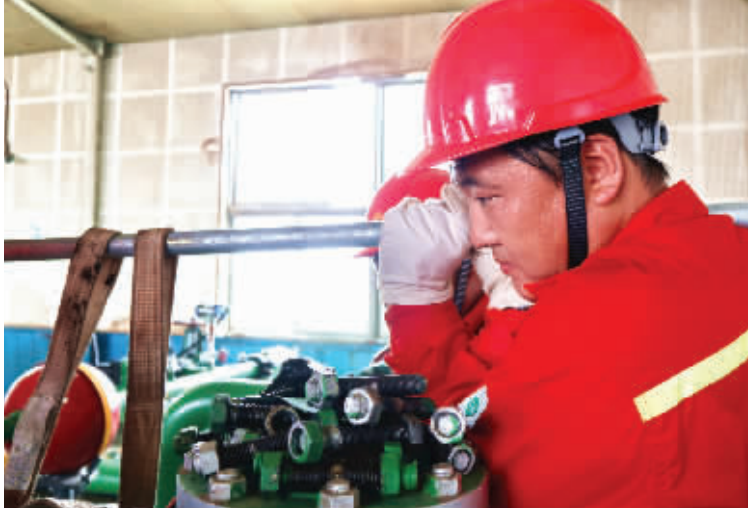
采油三厂集输作业区员工在注水泵房更换喂水泵出口阀门。(杨玲玉)
