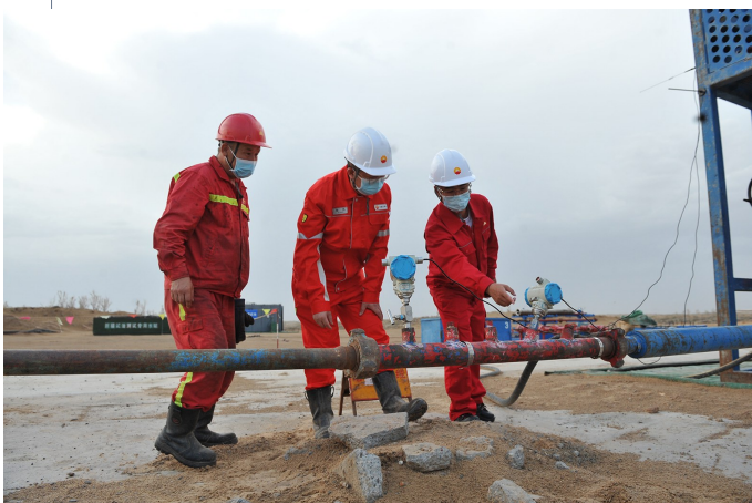
本报全媒体记者 王筱彤 摄 开发公司加强专业间的协作,保证全工序“无缝衔接”,保障试油施工提速提效。
