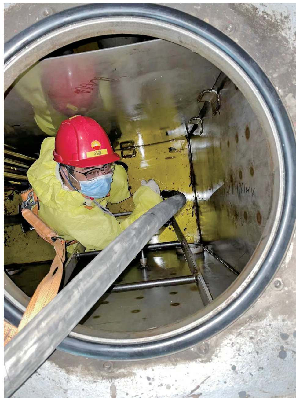
“弹丸之地”清理压缩机油箱。本报通讯员 马翔 摄
