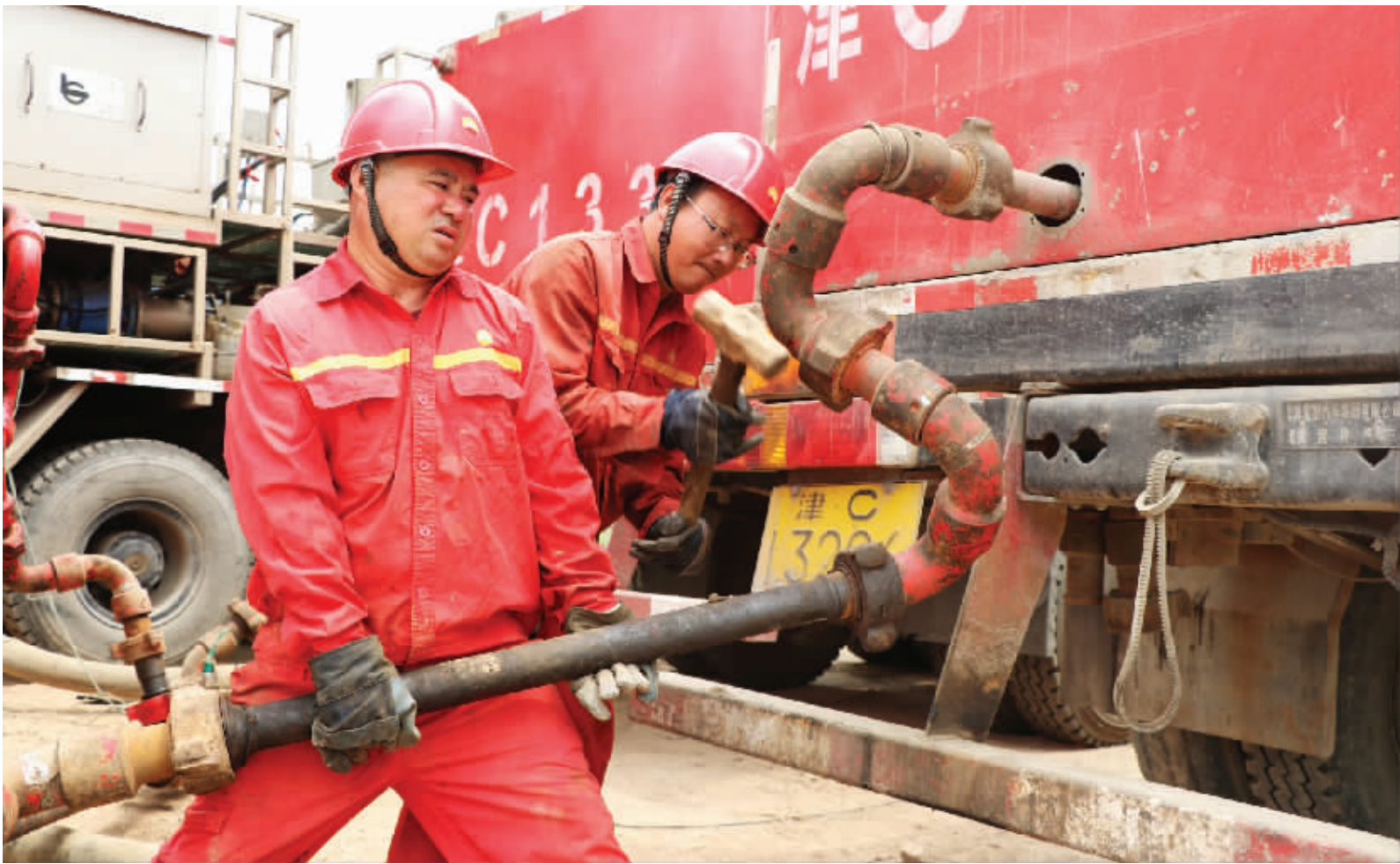
井下作业技术研发中心车组员工对硬管线进行紧固。(孙大虎)
