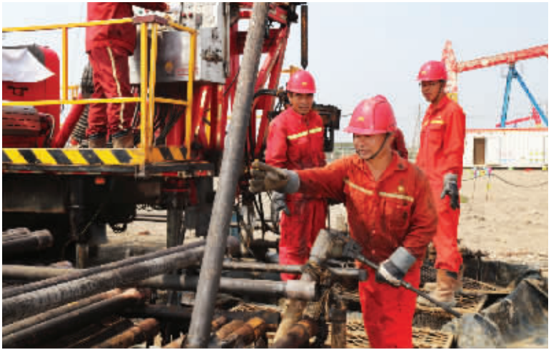
井下作业四修井 402 队员工在港古 17102 井下补孔管柱作业。(张鹏)
