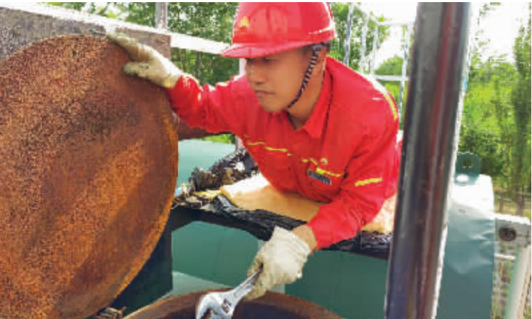
工业服务公司高层公司运维项目部司炉班组对辖区内锅炉、水泵、水罐、燃气管线等设备设施进行全面检修。(孙蕊)
