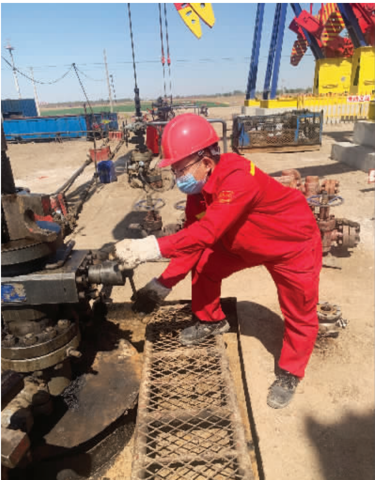
石油工程研究院防砂技术服务中心技术人员检查防砂井口防喷器密封情况。(朱英斌)
