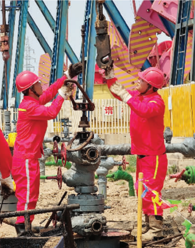
井下作业三修井 302 队员工在官 47-6-5 井提泵杆作业。(郝向华)
