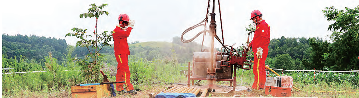
▲安全规范的“三标”作业现场
